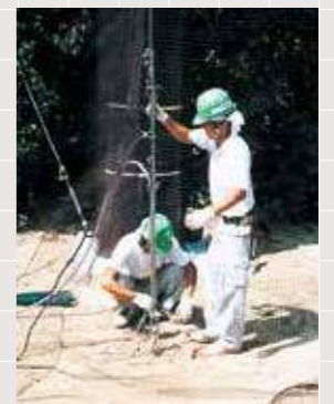
昇降ワイヤー取り付け
