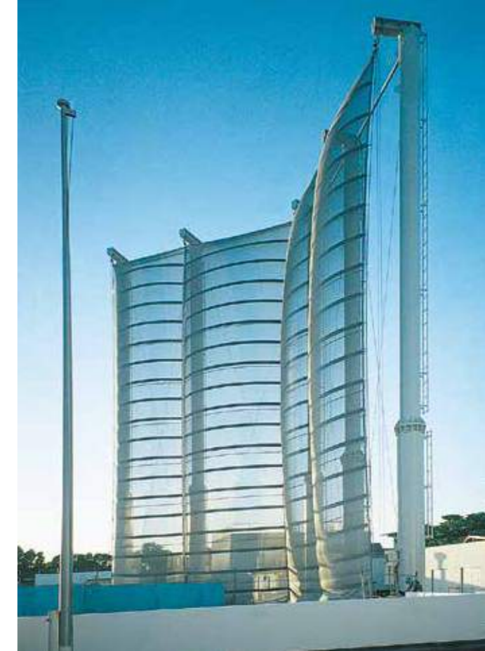
浜名湖競艇場 静岡県 / H=20m (防風) / DHT
