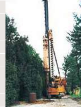
鋼管打設
