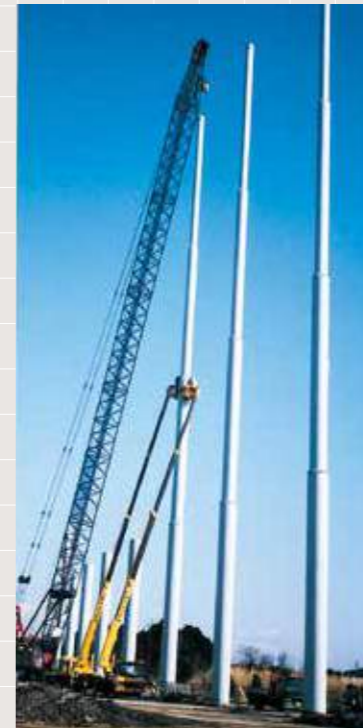
支柱ポールの建柱
