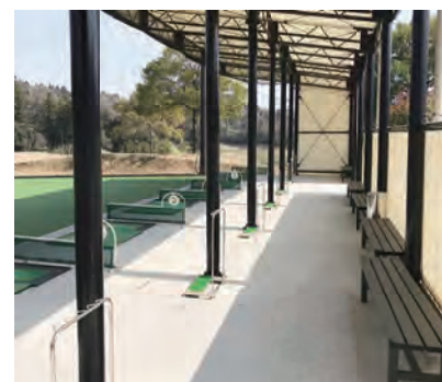
三重 Kゴルフ場内(打席上屋工事)
