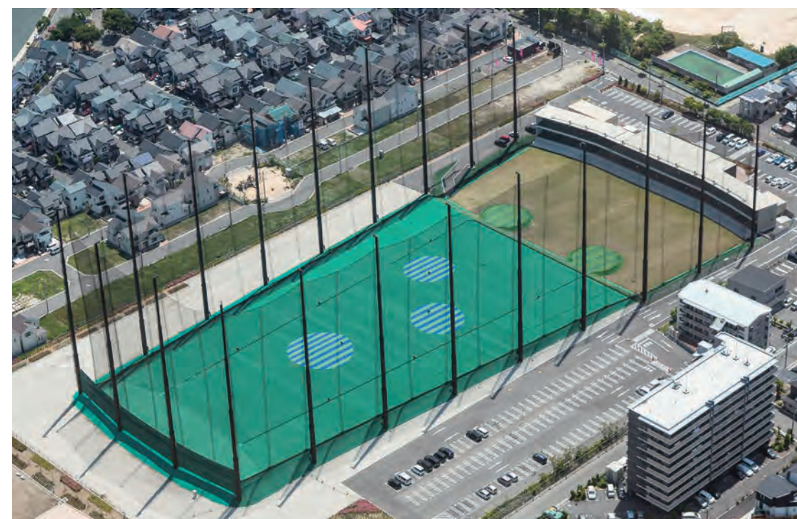
地上高さ59m 大阪 H練習場
